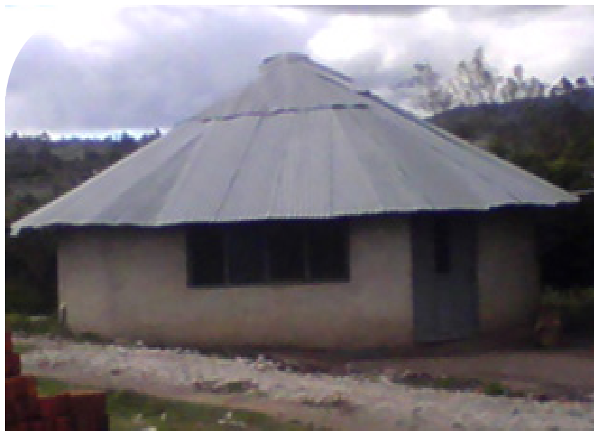
► Casa circular de lo frío en ladrillo y zinc. Vereda La Jardinera - Foto: Devamo
