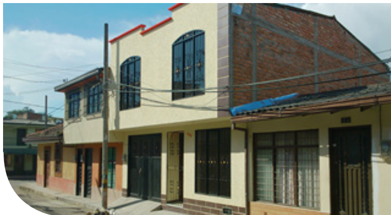
Casa de uno y dos pisos con techo de eternit - Foto: Devamo ◀
